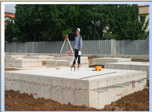
1STEP 콘크리트 타설 후 바닥level 체크
