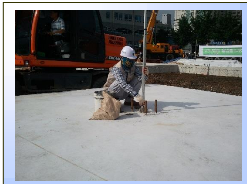
2STEP 기둥 설치 level 설정
